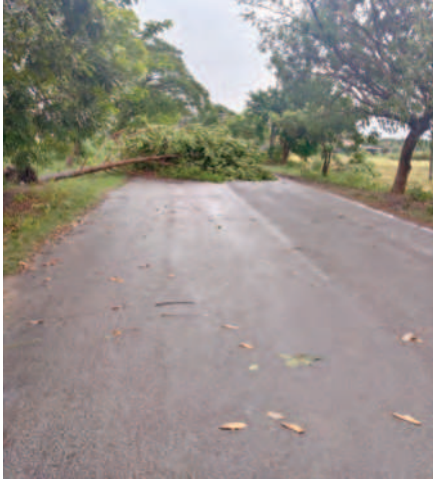
చిన్నకోడూరు-ఇల్లంతకుంట రోడ్డుపై విరిగిపడిన హరితహారం చెట్లు
